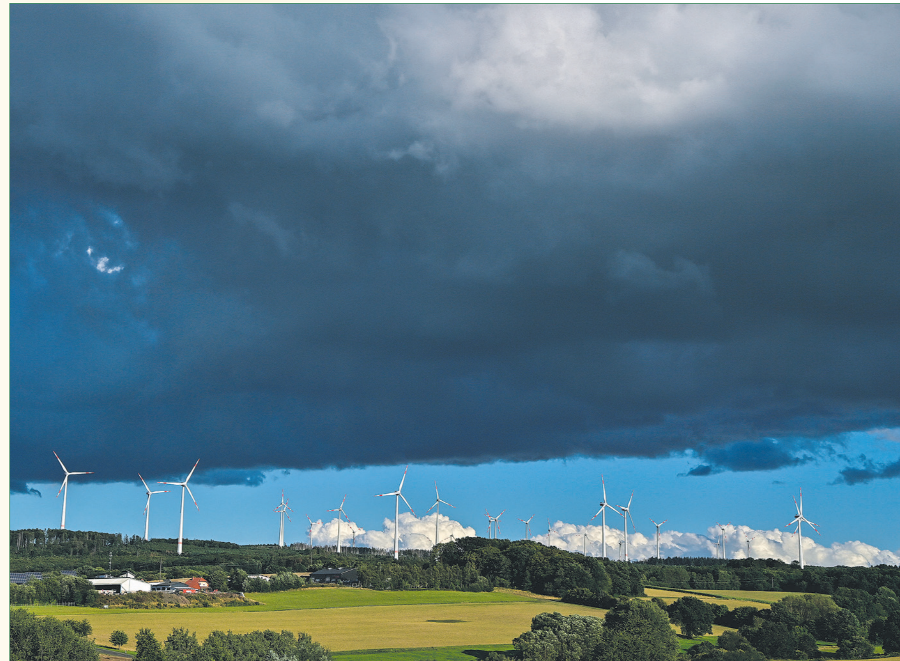
Klimaschutz: Eines der Windräder im „Windpark Hartenfelser Kopf“ dreht sich für die AEKS. An solchen guten Standorten im Westerwald kann eine Windkraftanlage jährlich rund 15 Gigawattstunden Strom erzeugen, vermeidet somit gegenüber der Stromerzeugung mit Braunkohle etwa 6.000 Tonnen des klimaschädlichen CO 2 .
